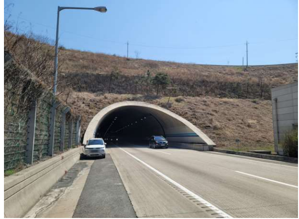
3공구 군위터널(상주방향) (3공구) 종점부
