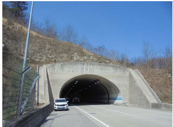
5공구 불로터널(영천방향) (5공구) 종점부
