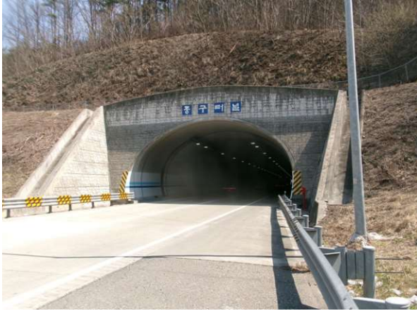
5공구 중구터널(영천방향) (5공구) 시점부
