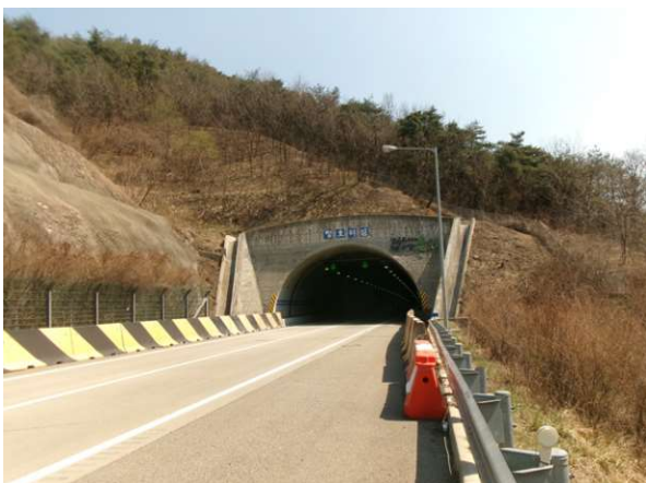
4공구 평호터널(영천방향) (4공구) 시점부
