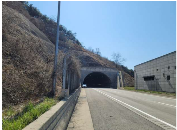
4공구 평호터널(상주방향) (4공구) 종점부
