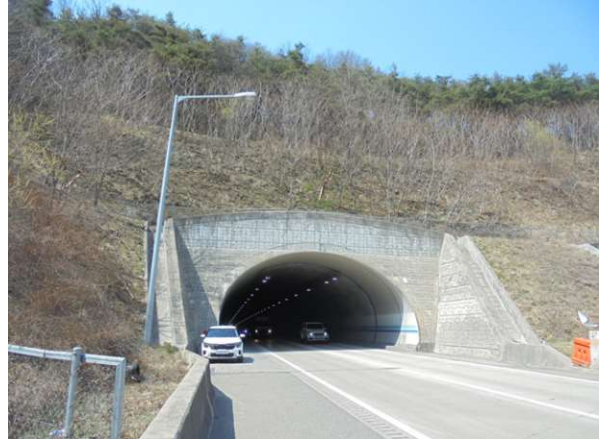
5공구 중구터널(영천방향) (5공구) 종점부
