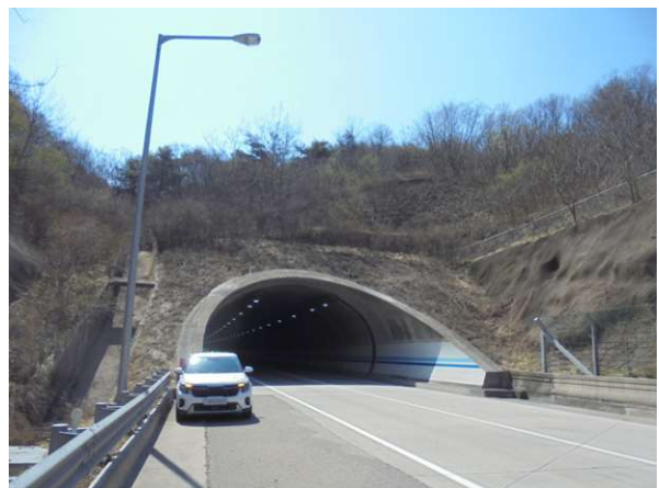
4공구 산법터널(상주방향) (4공구) 종점부
