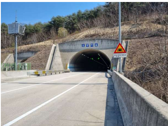
5공구 효령터널(영천방향) (5공구) 시점부
