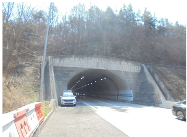
5공구 중구터널(상주방향) (5공구) 종점부
