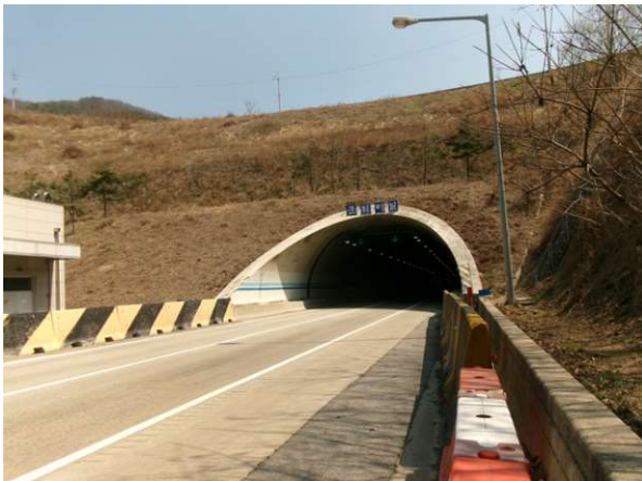
3공구 군위터널(영천방향) (3공구) 시점부
