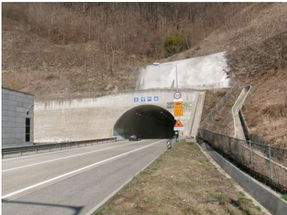
5공구 효령터널(상주방향) (5공구) 시점부
