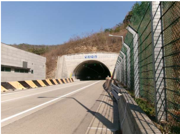
4공구 평호터널(상주방향) (4공구) 시점부
