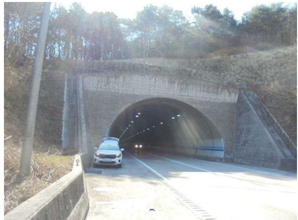
5공구 효령터널(상주방향) (5공구) 종점부
