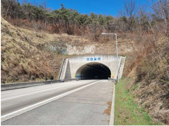
5공구 불로터널(상주방향) (5공구) 시점부
