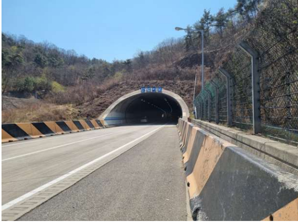
4공구 산법터널(영천방향) (4공구) 시점부
