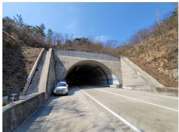
4공구 평호터널(영천방향) (4공구) 종점부
