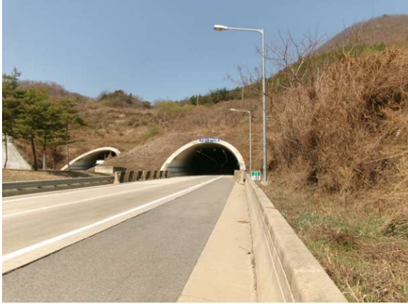
3공구 군위터널(상주방향) (3공구) 시점부
