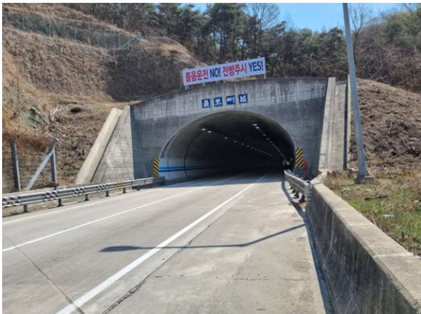
5공구 불로터널(영천방향) (5공구) 시점부
