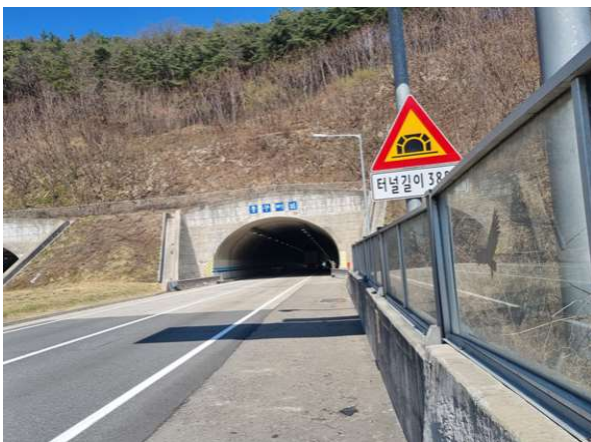
5공구 중구터널(상주방향) (5공구) 시점부
