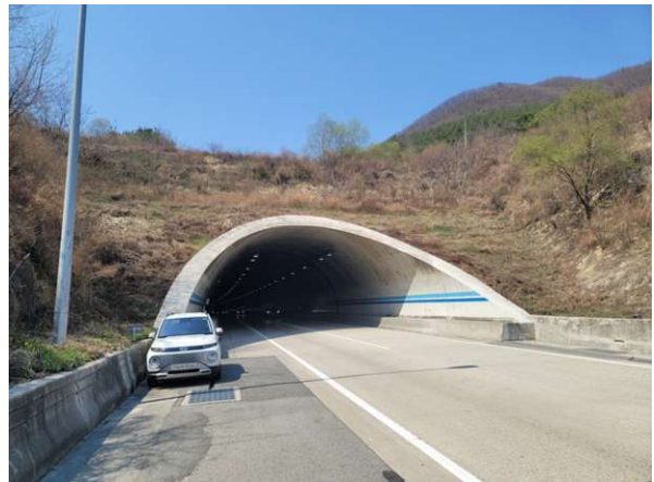
3공구 군위터널(영천방향) (3공구) 종점부
