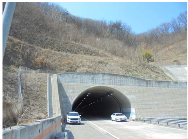
5공구 효령터널(영천방향) (5공구) 종점부
