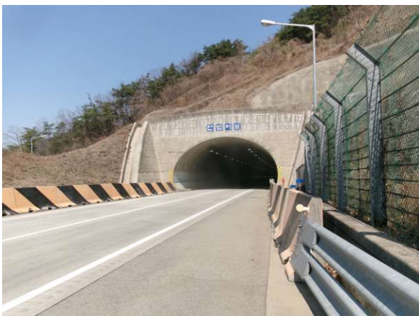
4공구 산법터널(상주방향) (4공구) 시점부
