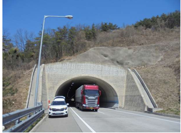
4공구 산법터널(영천방향) (4공구) 종점부
